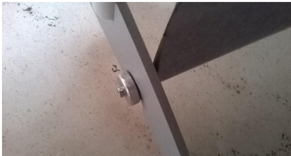
Пример за панел на кој шрафот му се олабавил и почнал да излегува од панелот.
